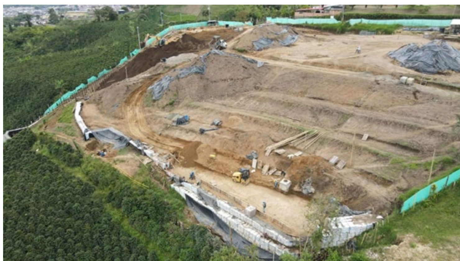
Foto 3: Muro en tierra armada
