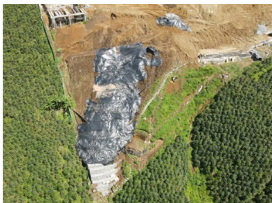
Foto 1: Zona de depósito de material de descapote.
